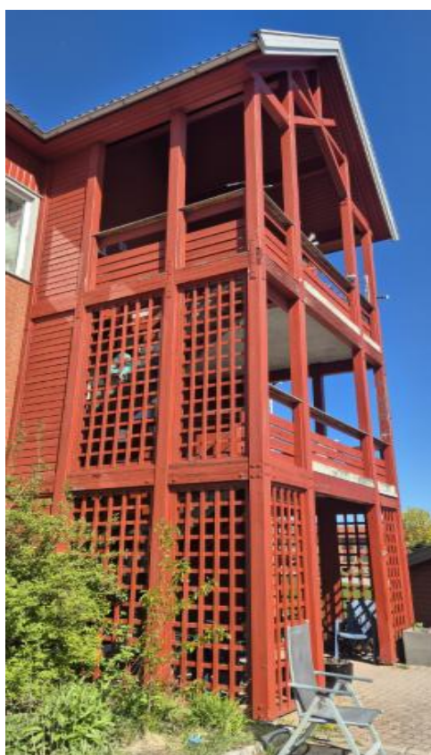
Hovedinngangsparti består av betongdekke, samt dragere og søyler i tre. Bærende konstruksjon av trev har store skader og må byttes ut. Balkongrekkverk må også skiftes ut. Pyntevegger/levegger på siden rives.
