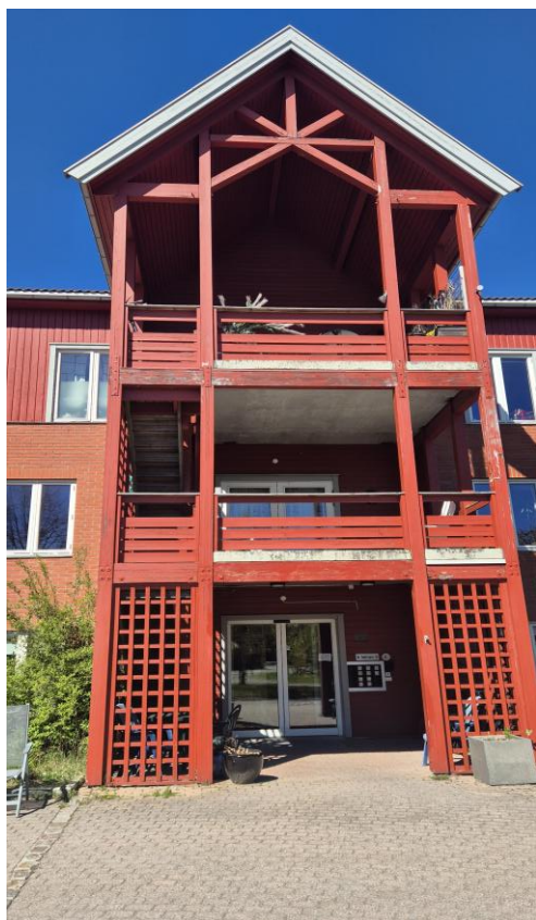
Hovedinngangsparti består av betongdekke, samt dragere og søyler i tre. Bærende konstruksjon av trev har store skader og må byttes ut. Balkongrekkverk må også skiftes ut. Pyntevegger/levegger på siden rives.
