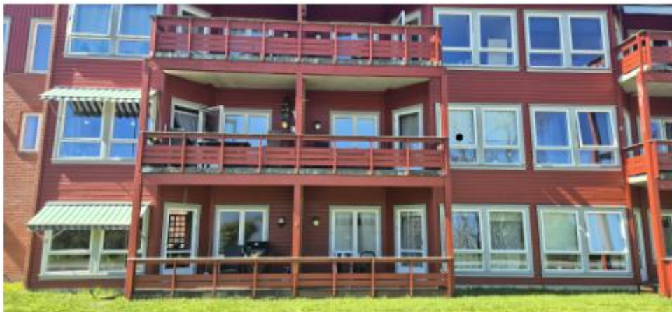
Balkongrekkverk i tre etasjer som må skiftes ut. Dagens rekkverk består av treverk og er festet inn i betongdekke, samt tresøyler.
